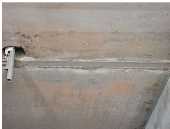
Foto N°04 – Sellado de juntas nivelado.
