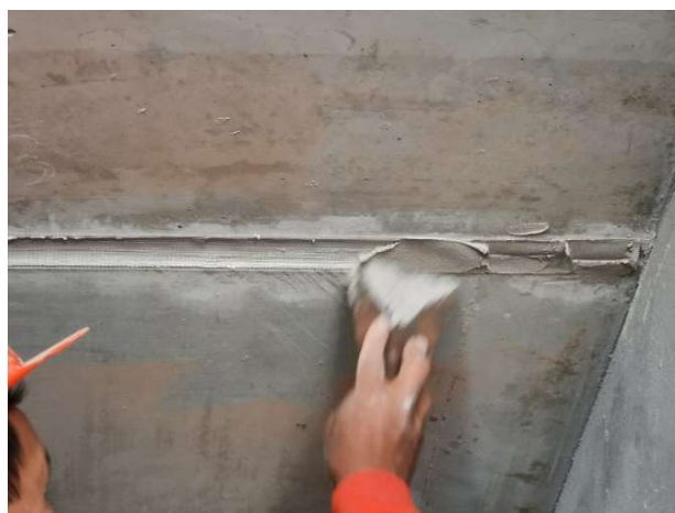
Foto N°01 - Aplicación de Pegamento Blanco Flexible en junta.
