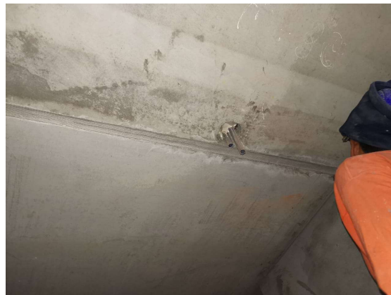
Foto N°03 – Pegamento Blanco Flexible y malla Drywall 3M.
