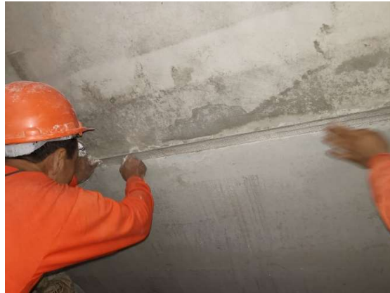
Foto N°02 – Colocación de malla Drywall 3M.
